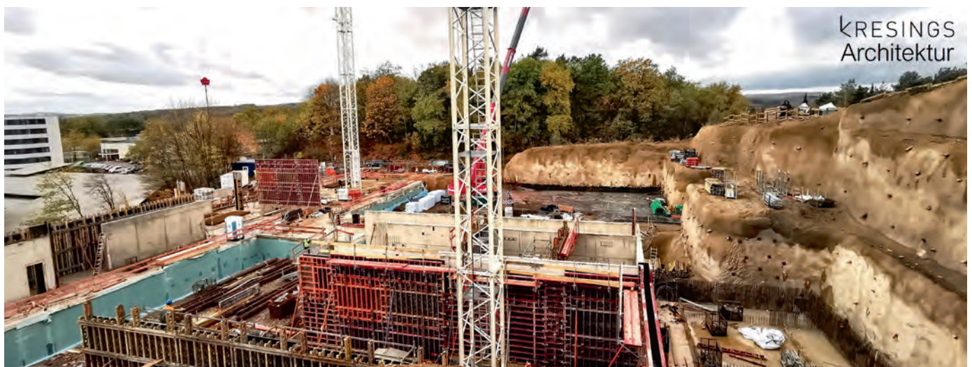
Abb. 3: Baufeld während der Erstellung des Erdgeschosses (Ost-Ansicht) mit ersten Wänden der Mikroskopielabore des MNaF-Seitentrakts im Vordergrund. Nach Fertigstellung des Gebäudes wird der Hang über diese Labore über eine Höhe von etwa 10 m aufgeschüttet und nachmodelliert.
